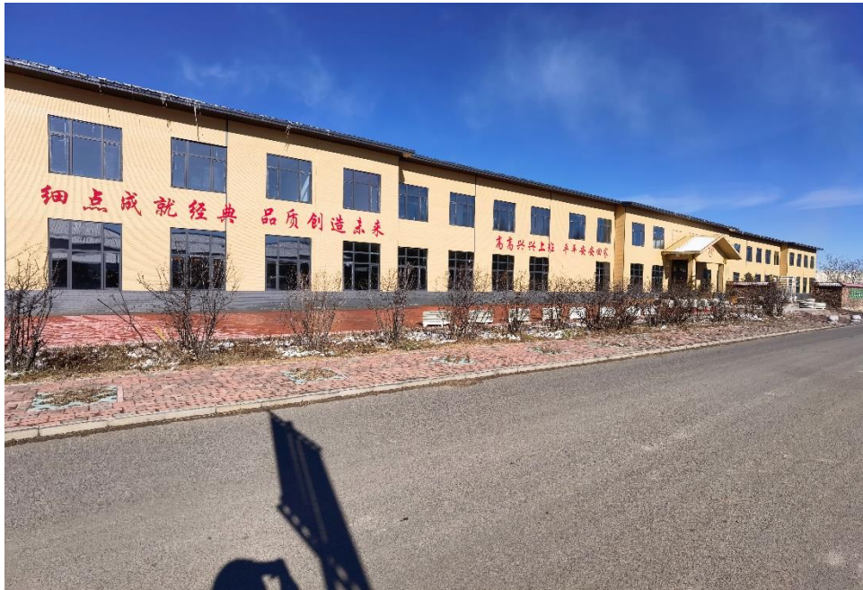
现有综合生产车间
